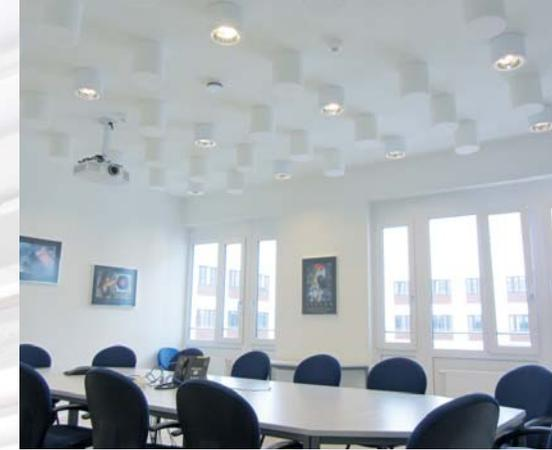
Absorber mit Verklebung und Deckenbeleuchtung
