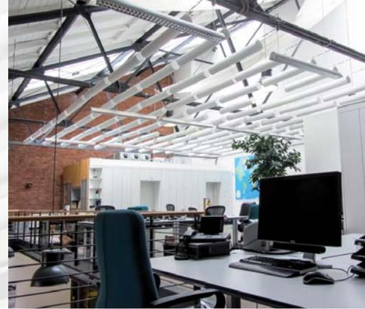
Absorber-Zylinder mit Seilsystem
