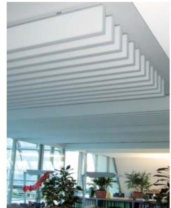
Büro mit Linearabsorbern zur Verbesserung der Sprachverständlichkeit (auch bei betonkernaktiven Decken).
