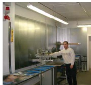
Wirkungsvolle Kombination von dicht an den Lärmquellen platzierten Absorbieren mit vollflächig absorbierend ausgestatteten Decken- und Wandflächen.
