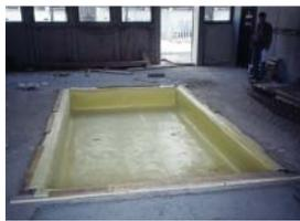
Das gesamte Fundament für eine Hebebühne wurde mit Sylomer® Typ M ausgekleidet.
