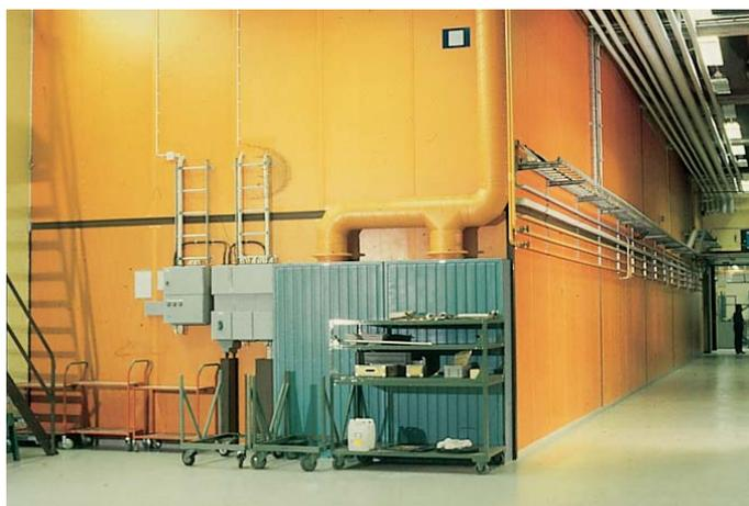
Schallschutzkapselung einer Großproduktionsanlage mit Deckenanschluss.
