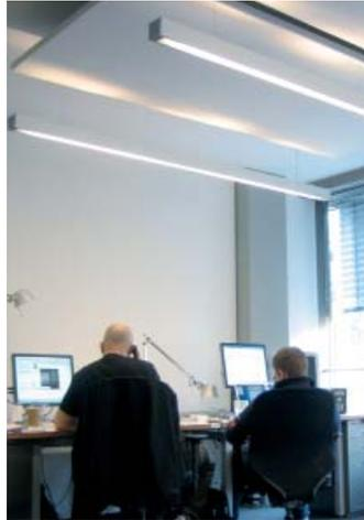
Abgehängte Akustik-Deckensegel bei betonkernaktiver Decke im Büro.
