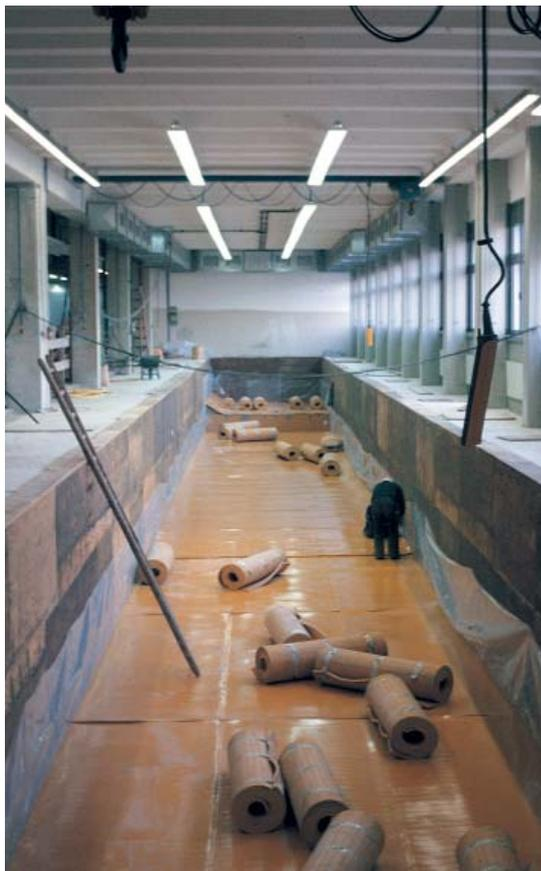
Durch die vollflächige Lagerung des Fundaments einer Crash-Test-Anlage auf Sylomer® kann das schwingfähige System auf unter 5 Hz abgestimmt werden.
