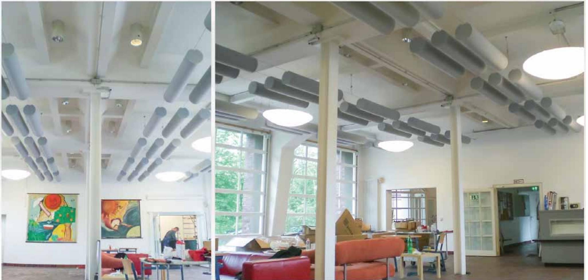
Wir liefern und installieren das Akustikdecken-System Typ WILLBRANDT Akustik-Zylinder in unterschiedlichen Durchmesser, Farben, Geometrie (nicht nur rund, auch gern hexagonal oder octogonal). Dabei stehen Abhängkonstruktionen aus T-Schienen oder Seilsystemem zur Auswahl.
