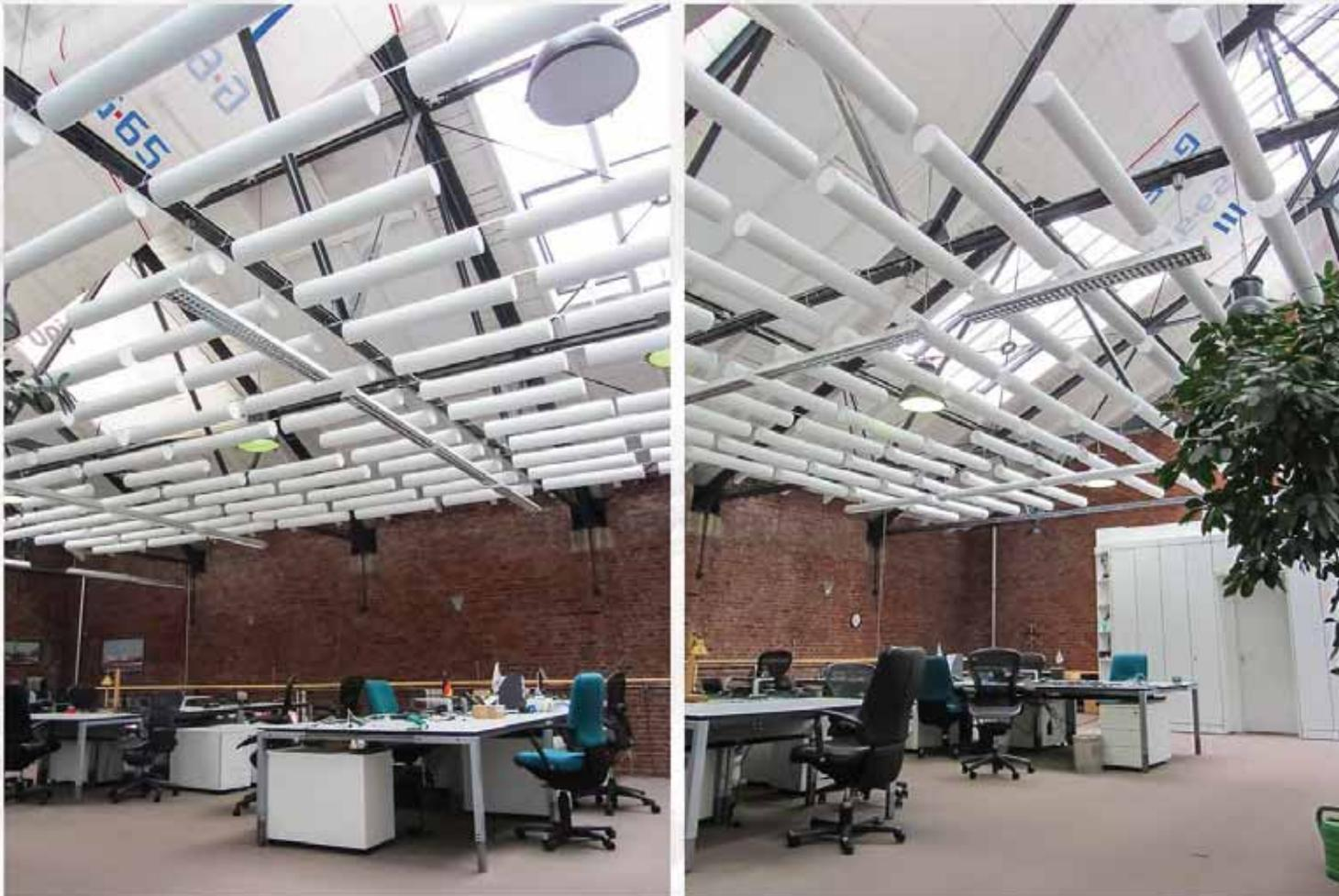
WILLBRANDT Akustik-Zylinder eignen sich insbesondere zur kostengünstigen Installation an einem Seilsystem, welches individuelle Reihenabstände ermöglicht. Tageslicht aus den Oberlichtern wird aufgrund des Achsenabstandes und der weißen Farbe nicht absorbiert. Hohe Decken behalten ihre Charakteristik.
