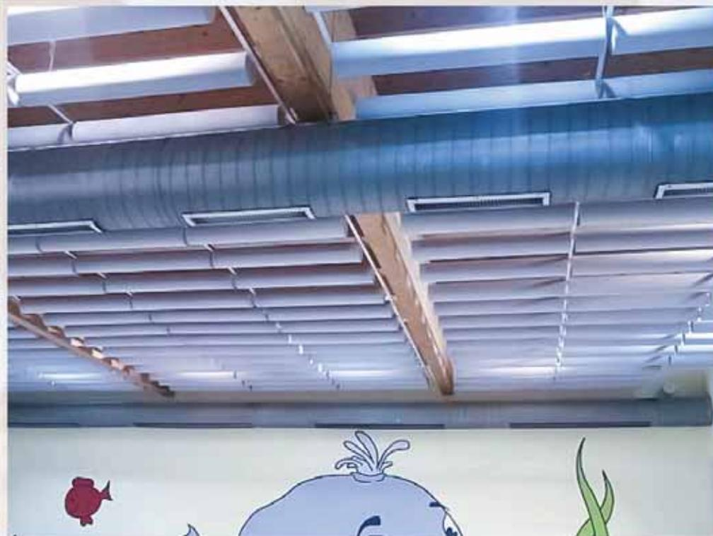
Schwimmbäder (Feuchträume), Büros, Kindergärten, Industrie-Hallen: Aufgrund der individuellen Anpassungsfähigkeit der WILLBRANDT Akustik-Zylinder an unterschiedliche bauliche Gegebenheiten ist dieses Absorbersystem nahezu universell einsetzbar.
