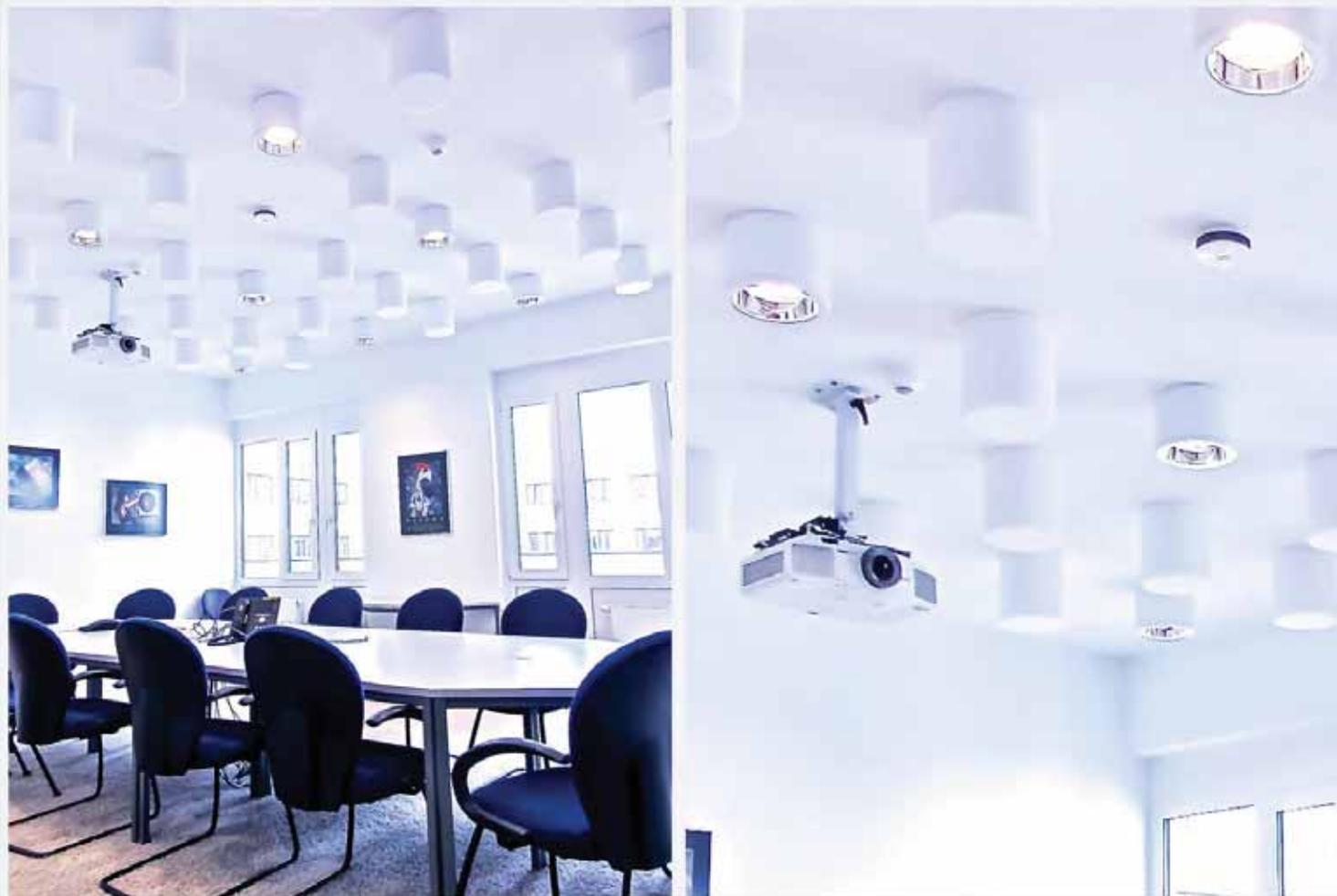
Sowohl ein Beamer, Bewegungsmelder, Brandmelder, als auch zylindrische Deckenleuchten wurden optisch mit den WILLBRANDT Akustik-Zylindern in Einklang gebracht. Die Betonkernaktivierung der Decke funktioniert nach-wie-vor, da die Belegungsdichte bei ca. 30% liegt.
