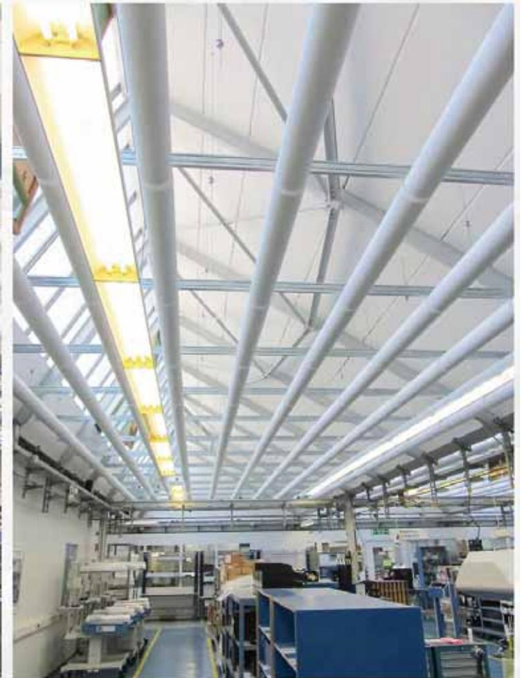
Deckeninstallationen (Leuchten, Kabelkanäle,...) können sowohl in Längsrichtung der Absorber, aber auch quer zum Absorbervverlauf montiert werden. WILLBRANDT Akustik-Zylinder bieten durch die individuelle Anpassungsmöglichkeit an vorhandene Deckeneinbauten zahlreiche Variationsmöglichkeiten.
