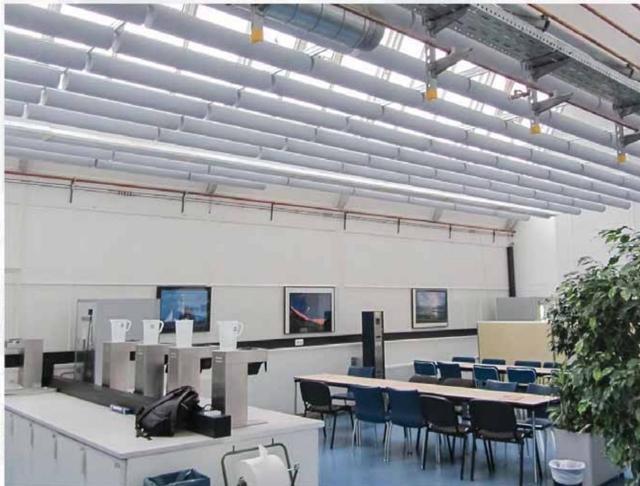
Die Lichtqualität von Arbeitsräumen wird durch den Einsatz von WILLBRANDT Akustik-Zylindern nicht beeinträchtigt, da weiterhin durch die gewählten Achsabstände und die helle Farbe der Absorber kein Licht absorbiert wird. Deckeninstallationen (Leuchten, Kabelkanäle) werden harmonisch integriert.
