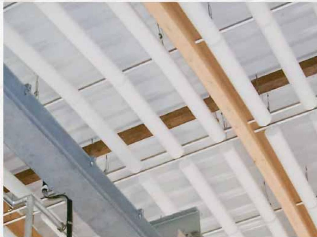
WILLBRANDT Akustik-Zylinder können bei gewölbten Decken sowohl in Längsrichtung, als auch quer zur Deckenwölbung harmonisch integriert werden.
