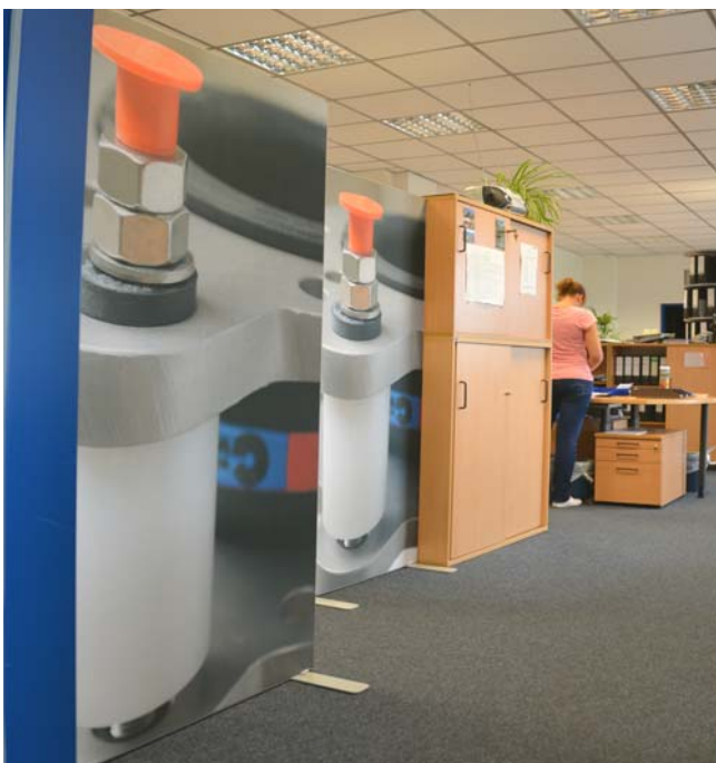
Durch versetzt angeordnete Akustik-Stellwand-Module wird ein Durchgangsbereich ermöglicht: Der Lärm wird überwiegend abgeschottet.
