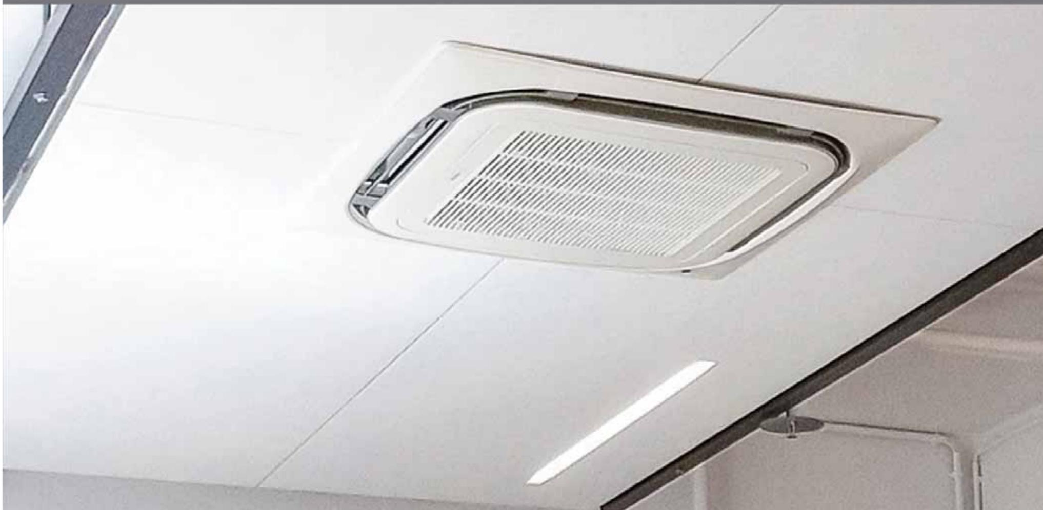
Projekt: WILLBRANDT-Akustik-Deckensegel mit integrierten Leuchten und Unterbau Klimagerät.4 St. Akustik-Segel wurden mit Stoßfugen zu einem Cluster zusammengesetzt.Lichtreflexion Akustik Segel: 87%.
